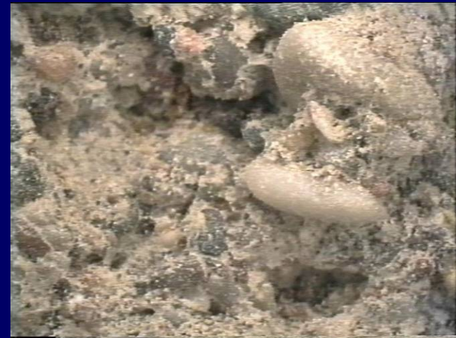
Επιφάνεια σκυροδέματος x25 του κτιρίου Ροτόντας
