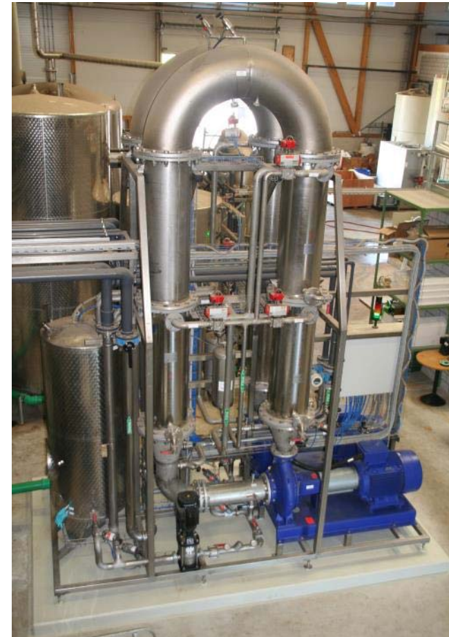
Abb. 4: Ultrafiltrationsanlage in Inwil (Schweiz)
